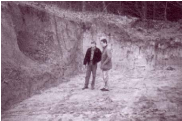
Der Abschlusswall wird im Geschosseinschlagbereich ausgebaggert...
