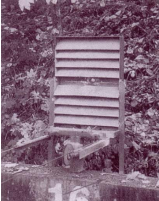
Stahllamellengeschossfang mit Bleiablagerungen (Rotpfeil)
