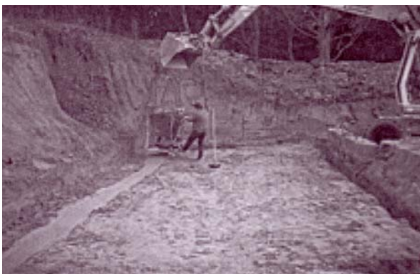
Dann werden nach der Bodenbeprobung die Fundamente gegossen.
