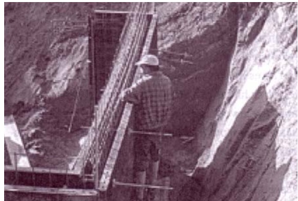
und die Seitenwände errichtet.
