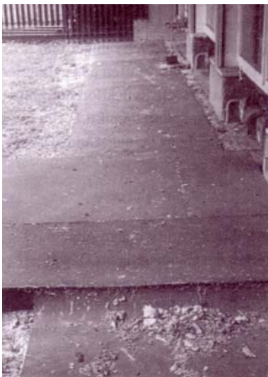
Abdeckung der Schießbahnsohle mit Gummigranulatmatten
