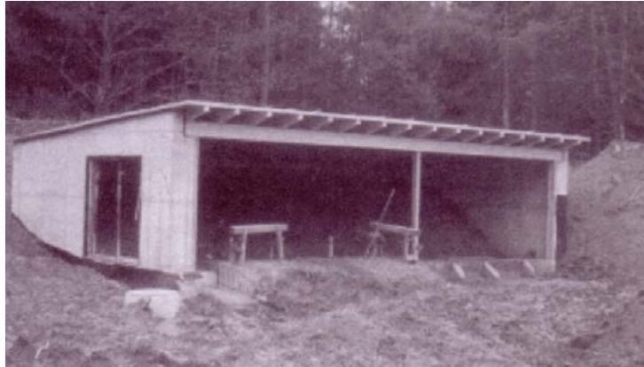
Wird noch das Fangdach aufgebracht, die Geschossfangkammer ist fertig.
