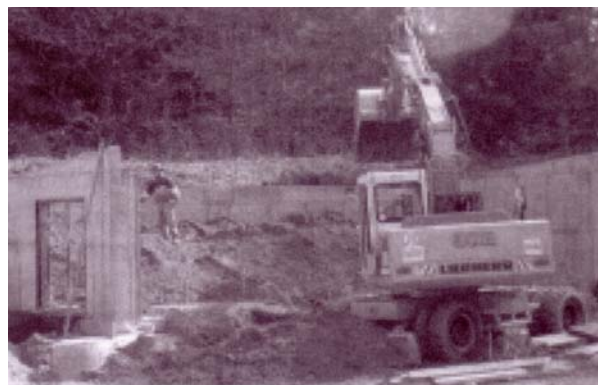
Nach dem Einfüllen des Bodenaushubs...
